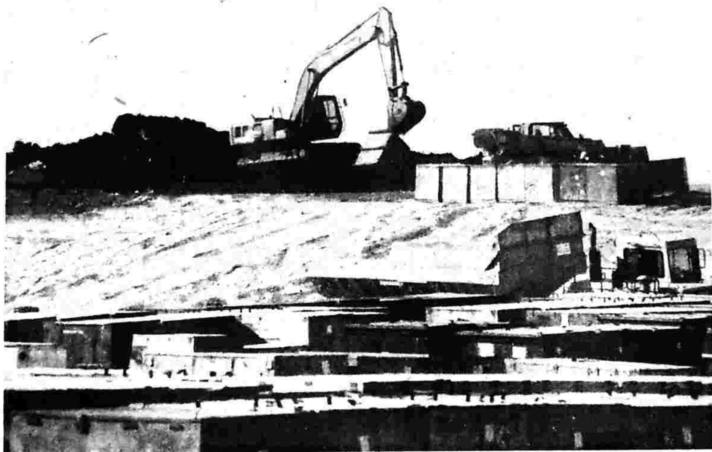
زباله‌های پرتوزا و شیمیایی در یکی از تأسیسات دفع زباله تخلیه می‌شوند که در آنجا در گودالی با دیواره‌های خاک رس نگاه داشته می‌شوند.
