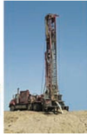
دکل حفاری چاه آب
