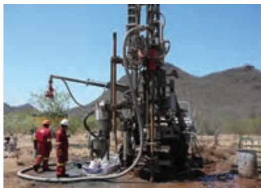
ب) دستگاه حفاری گمانه
