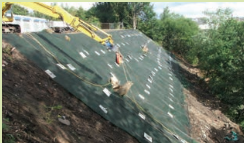
پایدارسازی شیب به روش میخ‌کوبی
