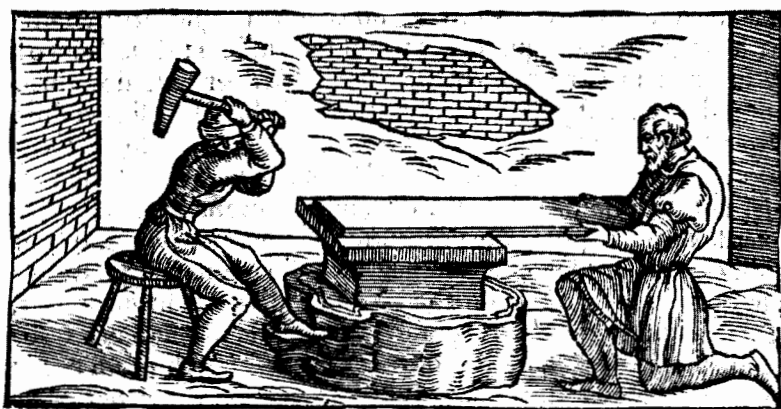
شکل ۴۲- چکش کاری ورقه‌های برنج: درباره‌ی فلز گذاری اثر بیرینگوتچو، ۱ و نیز، ۱۵۴۰.
