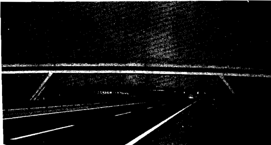
شکل (۲ - ۶) - پل قابی با پایه‌های مورب بر روی اتوبان
