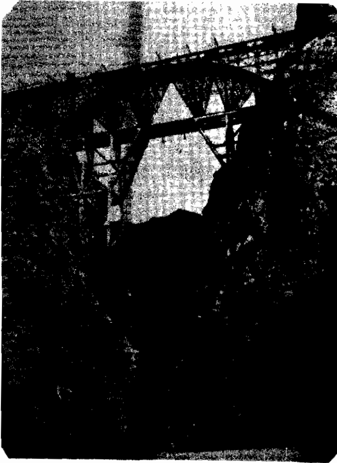
شکل (۲ - ۲۵) - اجرای پل ورسک توسط داربست ثابت در ایران .
