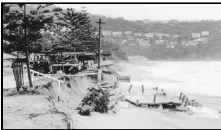
شکل ۳-۱۹-ب) همین طوفان در سواحل دیگر بیش از ۴۰ متر فرسایش ایجاد نمود- تصویر ساختار فروریخته در اینجا سرپناه یک میز پیک نیک بوده است که در ارتفاع ۵ متری ساحل و در پرتگاه قبلی وال بیچ در سیدنی قرار داشته است.
