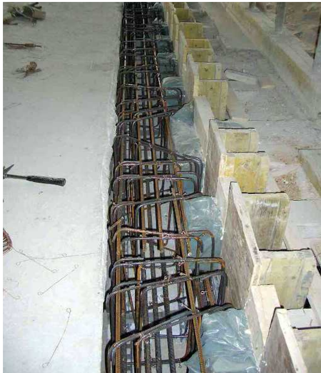
مهار آرماتورهای کف جدید در دیوارهای بنایی.
