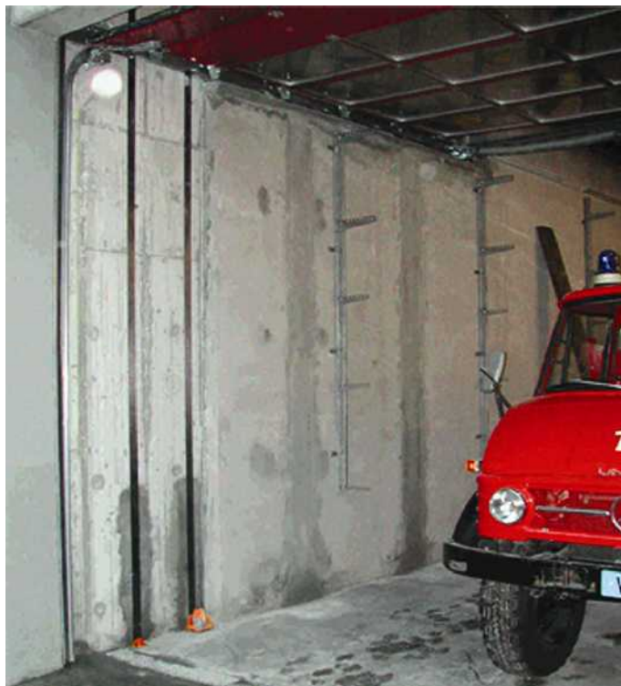
دو عدد از نوارهای CFRP پیش‌تنیده در وجه داخلی دیوارهای گوشه ساختمان (تروففر و همکاران، ۲۰۰۴)
