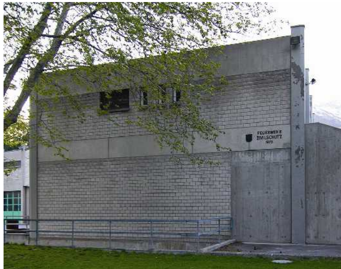
دیوارهای گوشه ساختمان که با نوارهای قائم CFRP تقویت شده‌اند.
