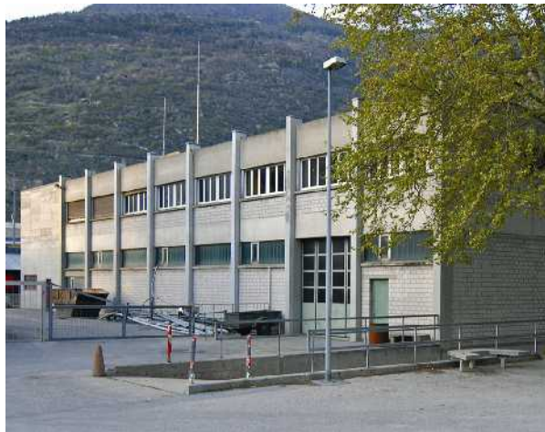
نمای طولی پشت ساختمان ایستگاه که توسط دیوار بتن مسلح سازه‌ای در منتهی‌الیه چپ تقویت شده است.
