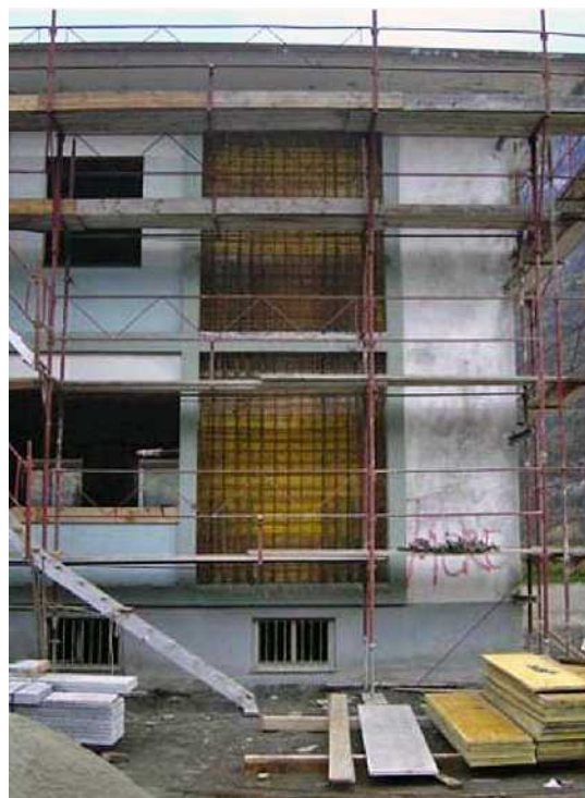
آرماتوربندی دیوار بتنی سازه‌ای در نمای امتداد طولی.
