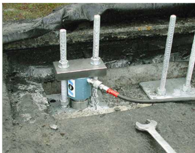
پیش‌تنیدگی نوارهای CFRP در سقف بتنی (تروففر، همکاران ۲۰۰۴)
