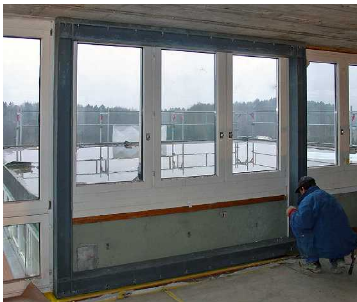
مهاربندی تراز بام ساختمان با استفاده از قاب‌های فولادی جدید.
