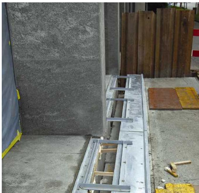
تعبیه درز انبساط در اطراف ساختمان حرکت افقی بالتک‌های لرزه‌ای جدید را ممکن ساخت.
