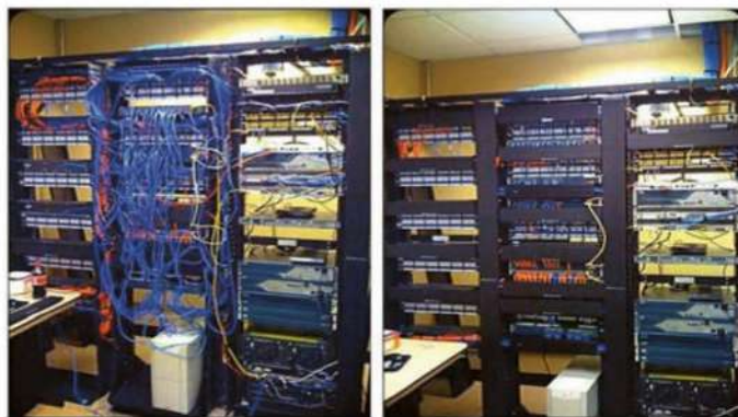
شکل ۴۱- مرتب کردن کابل‌ها
