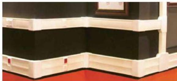
شکل ۵۳ - محل تقاطع ترانک‌ها و داکت‌ها
