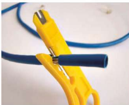
شکل ۲۵- لخت کردن سر کابل
