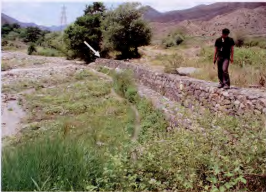
تصویر ۲-۱۸- ایجاد دیواره‌ی گابیونی طولی موازی با جهت جریان در رود تالار نزدیکی غار اسپهبد (دید به سمت جنوب)
