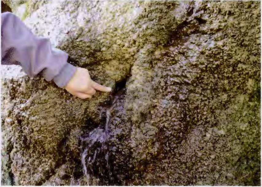
تصویر ۳-۱۳- چشمه‌ی درز و شکافی در داخل طبقات سازند دلیچای منطقه‌ی اندوار (دید به سمت شرق)
