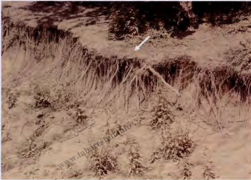
تصویر ۲-۱۷- میزان گسترش و نقش ریشه گیاهان در حفاظت از خاک، جاده‌ی کیاسر (دید به سمت شرق)
